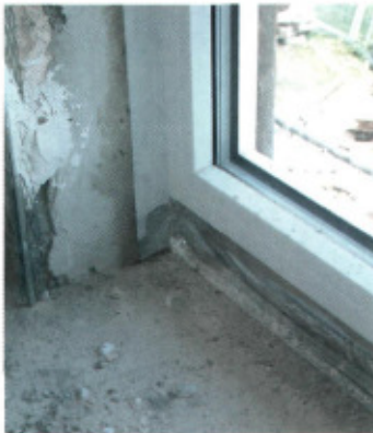
Folienabklebung der Fenster-/Wandanschlüsse zur Gewährleistung der Winddichtigkeit
