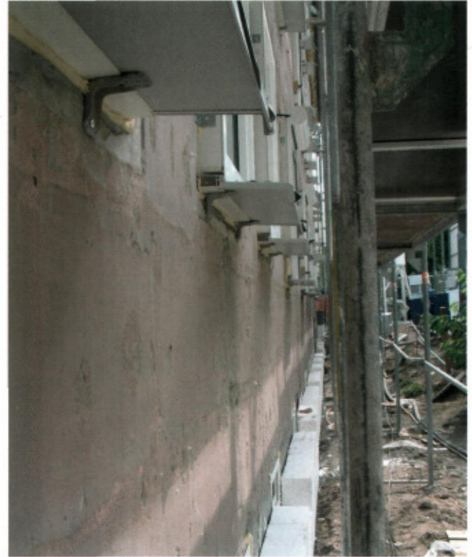
Beim Fenstereinbau wurde besonders auf die Winddichtigkeit der Fensteranschlüsse geachtet
