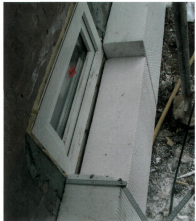
Wärmedämmverbundsystem 20 cm Neopor
