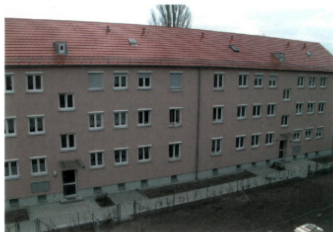
Nach EnEV fertig gestellter 1. Umbauabschnitt
