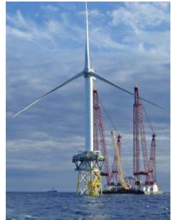
Montage von Repower- Windenergieanlagen auf Hoher See
