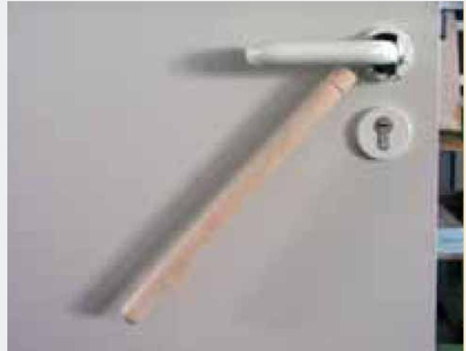
Lösung: Eine einfache Hebelkonstruktion ermöglicht die Bedienung von Türgriffen in Standardhöhe auch Rollstuhlnutzern und Kindern.
