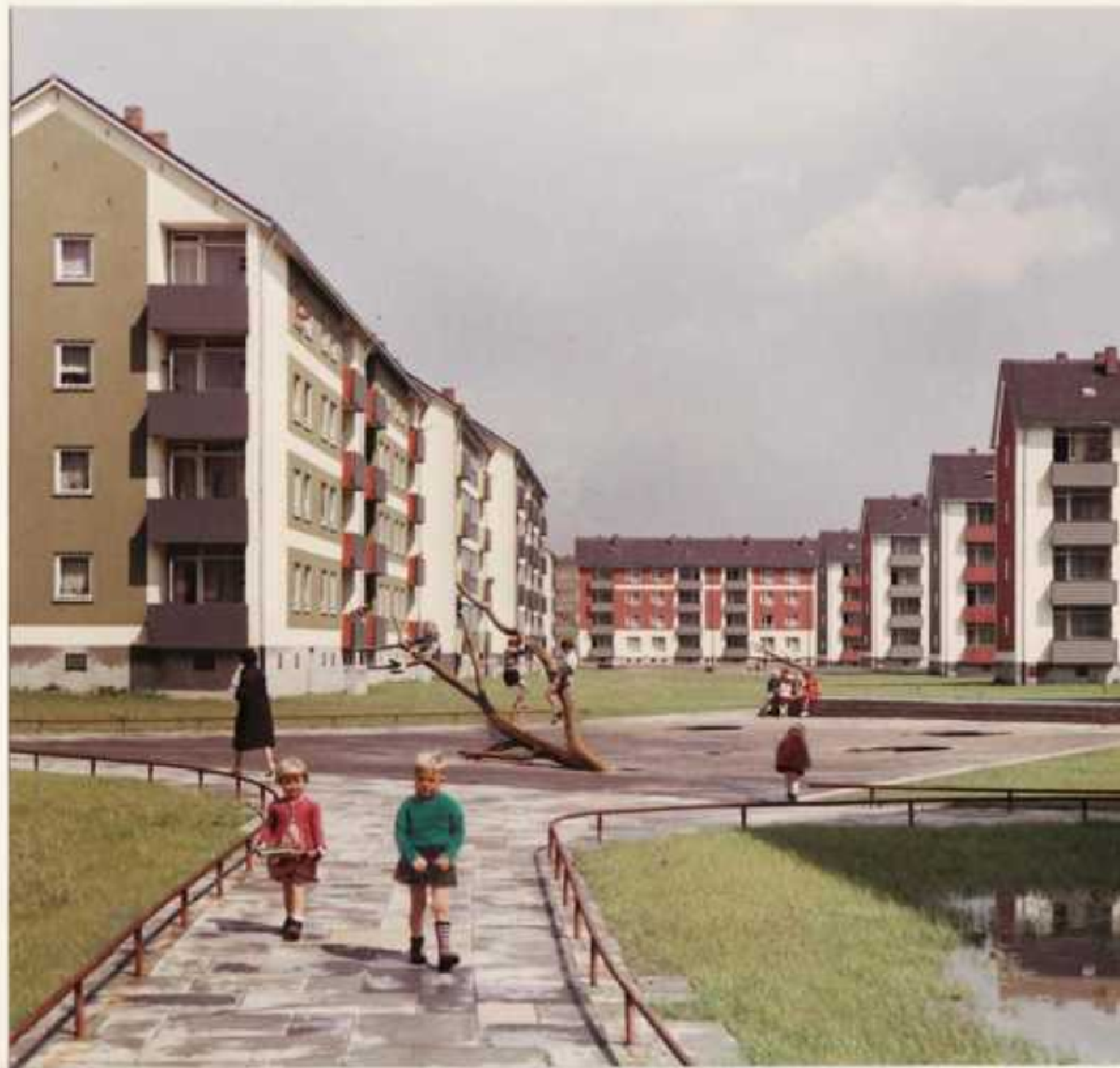
Köln-Vingst, Garten- und Spielplatzanlagen zwischen den Wohnblocks Thorwaldsen- und Hebelstr.
