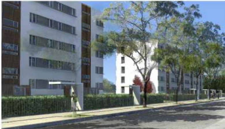
Façade Nord après travaux
