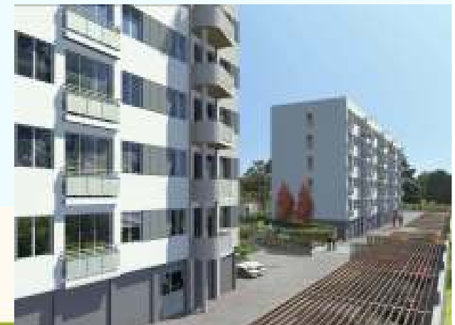
Façade Sud après travaux
