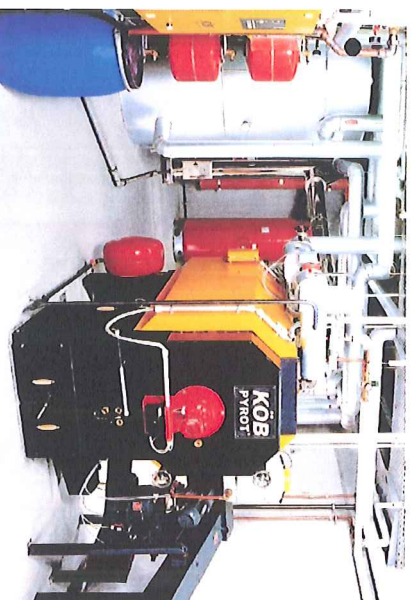
Holzpelletkessel, Bauweise wie Magdeburger Straße 2
