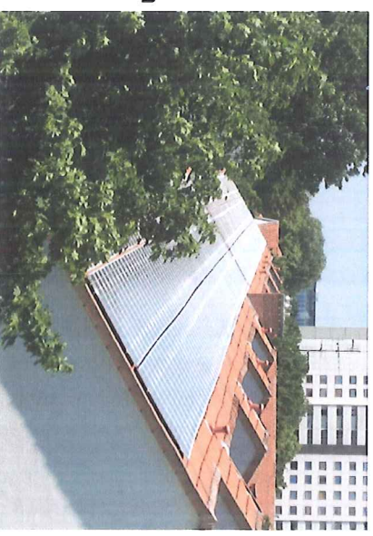
Dachfläche mit 408 monokristallinen Modulen
