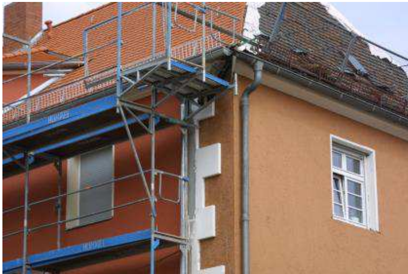
Energetische Sanierung einer Hausfassade
