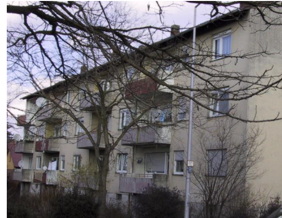
Frobeniusstraße 10-12 vor Mod.
