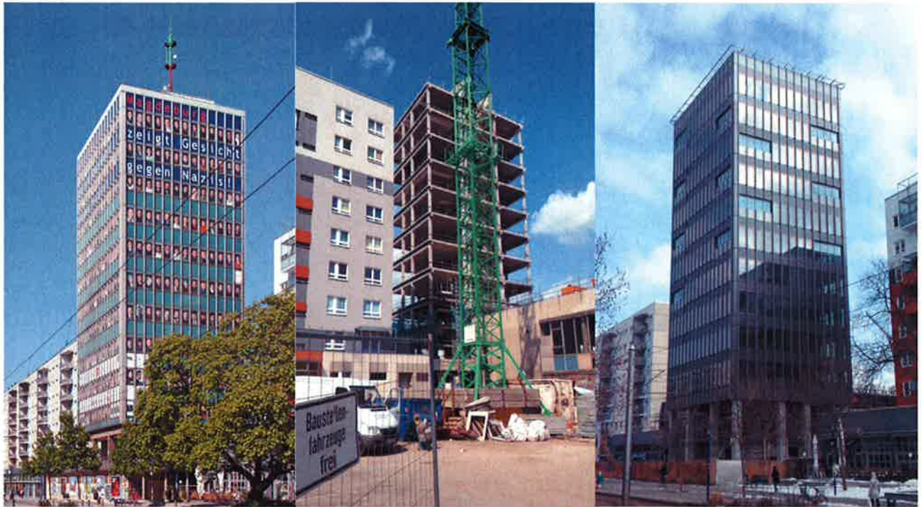
Fotos oben (v. links n. rechts): HDL vor der Sanierung, das komplett entkernte Gebäude, fertiggestellte Fassade
