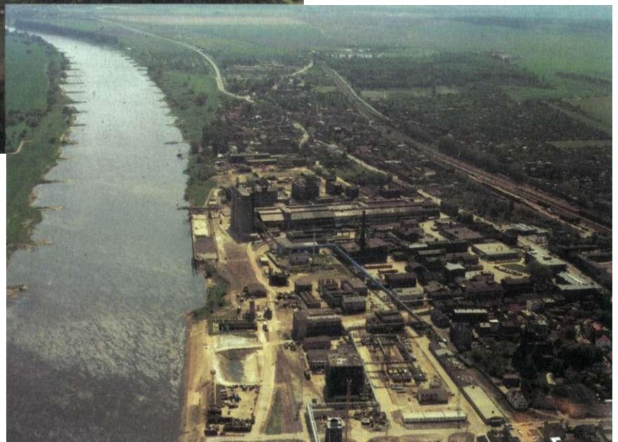
Blick über den ehemaligen Chemiebetrieb "Fahlberg-List" nach Süden.
