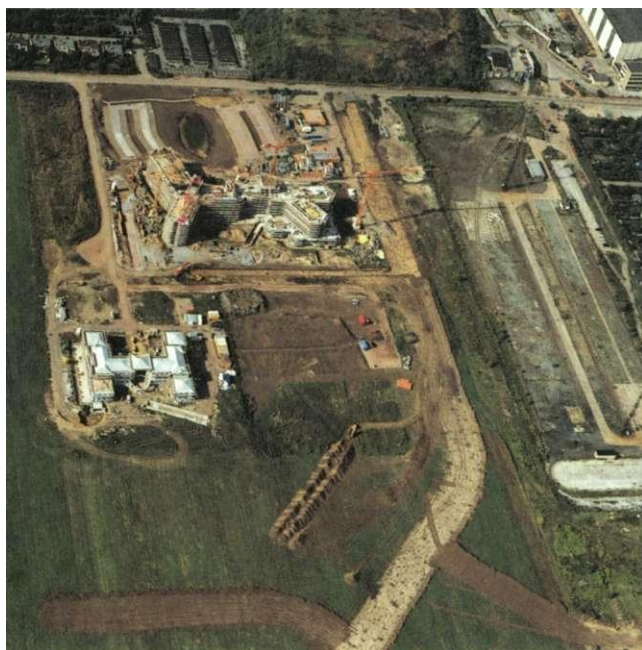
Büro- und Verwaltungskomplex "Synergis" nördlich des Flughafens
