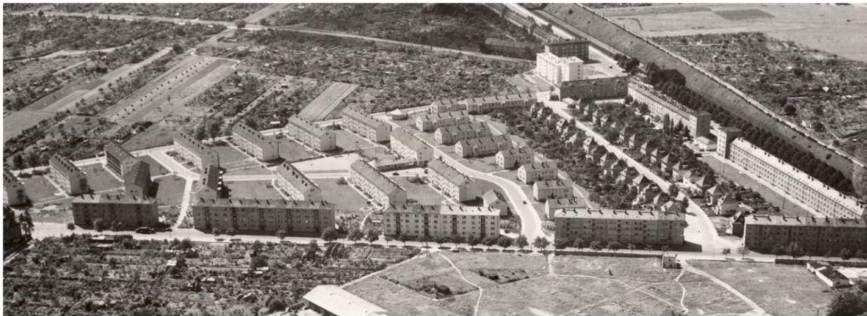
Foto aus nördlicher Richtung. Im Vordergrund die Bessunger Straße
