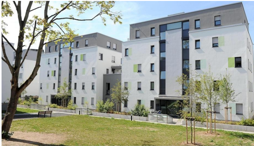
Optisch kaum zu unterscheiden: Links das nach EnEV 2009, rechts das als Passivhaus errichtete Gebäude. Bild: Kristina Schäfer/GWW
