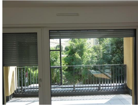
Rollladen läuft ungleichmäßig
