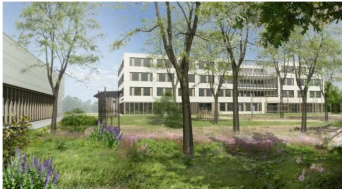
Grundschulneubau Am Thoner Espan
