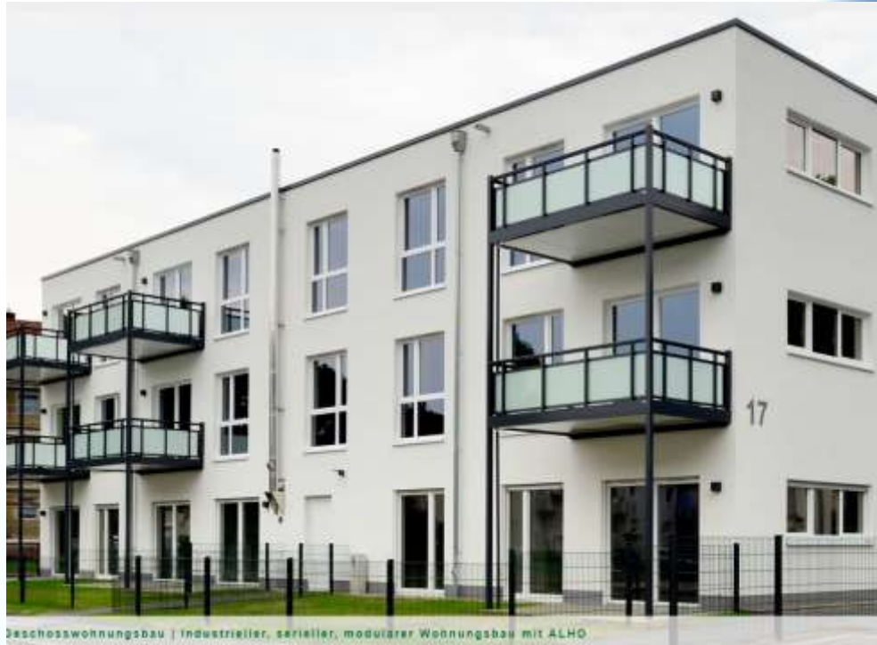
Basisschosswohnungsbau | Industrieller, serieller, modularer Wohnungsbau mit ALHO
