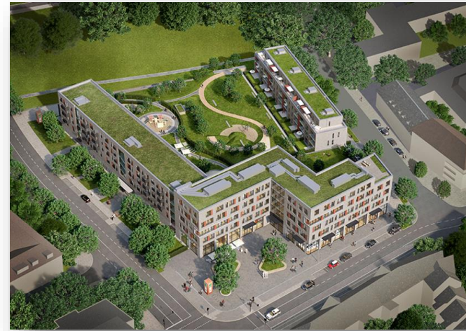
Energetische Modernisierung der Süd-Ost-Höfe, Allbau GmbH
