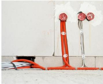
Während des Rohbaus lassen sich Leerrohre einfach Unterputz verlegen. Foto: Alterfalter/Fotolia.com Foto: ...
