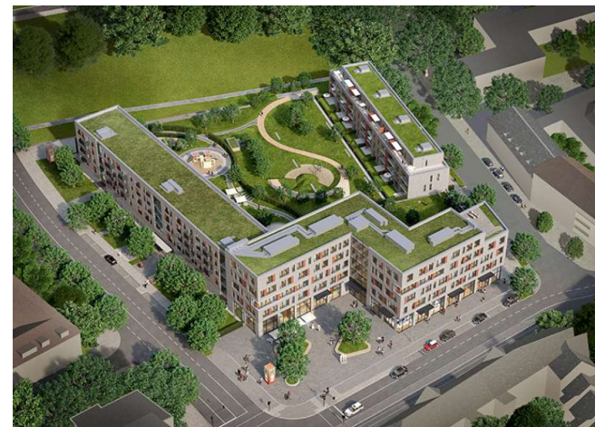
Energetische Modernisierung der Süd-Ost-Höfe, Allbau GmbH
