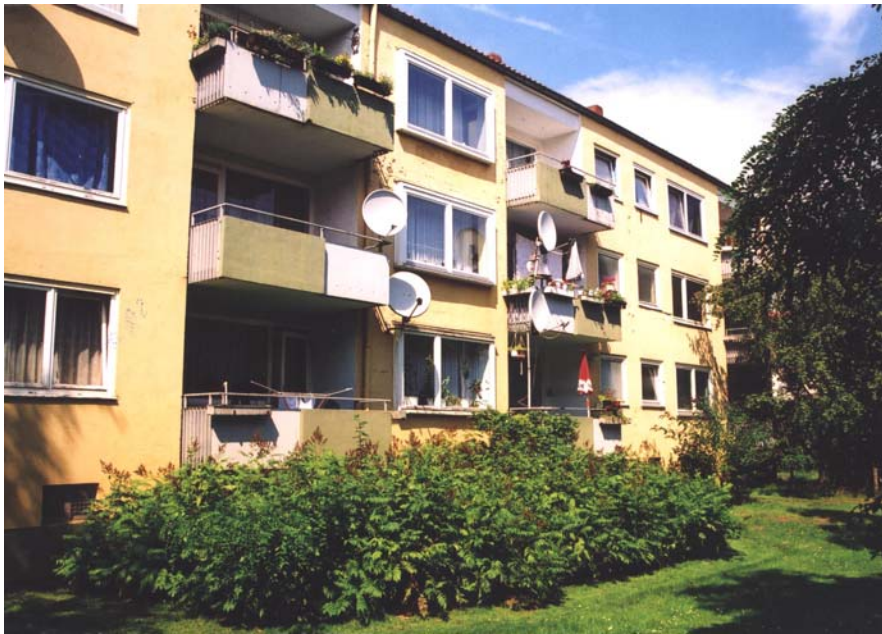
Leipziger Str. 22/24 vor der Modernisierung
