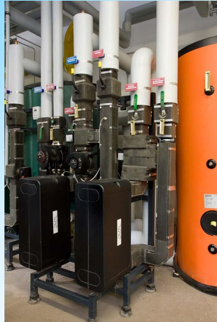
Die Speicher können sowohl einzeln oder als Gruppe in Reihen- oder Parallelschaltung eingesetzt werden. Der Speicherinhalt wird für jeden Einsatzfall optimiert. Bei Umrüstungen bietet sich an, vorhandene Trinkwasserspeicher für das Speichermanagement zu nutzen, da diese nicht mehr benötigt werden.
