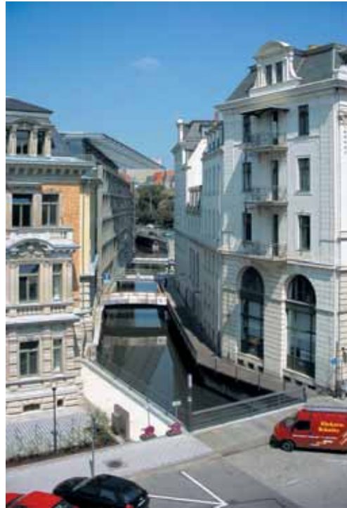
Abb. 36 Dorotheenbrücke im III. Bauabschnitt
