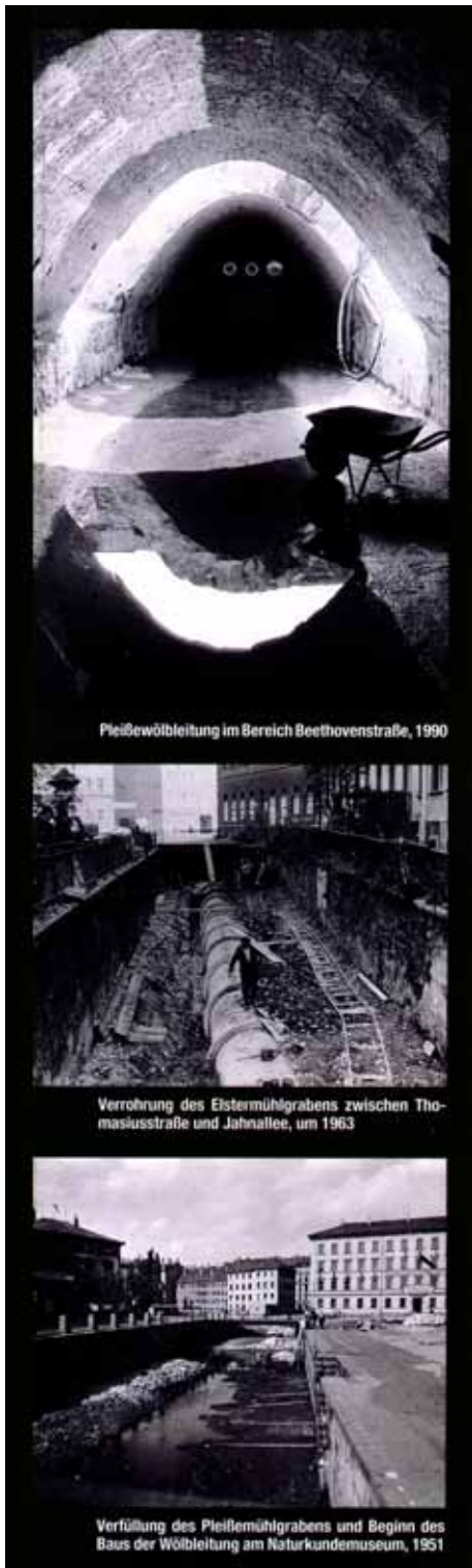
Abb. 33 Verrohrung des Flusslaufes
