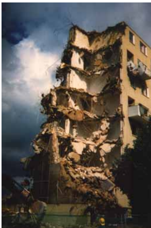
Abb. 8 Abbruch der Lenaustraße 64
